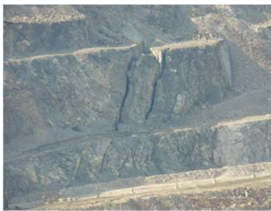
Сурет 2.6 – Карьер жағдаулары таужыныстарының жарықшақтылығы [28]
